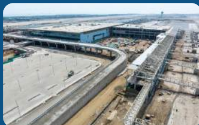
AMPLIACIÓN DEL AEROPUERTO JORGE CHÁVEZ
